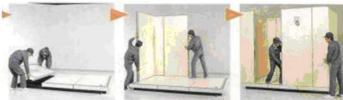
Lắp ghép panel kho lạnh
